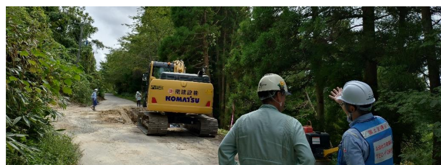
道路啓開班（珠洲市）
