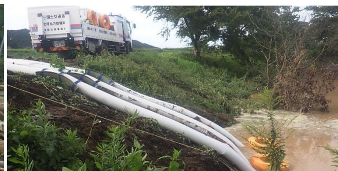
排水ポンプ車派遣（輪島市）
