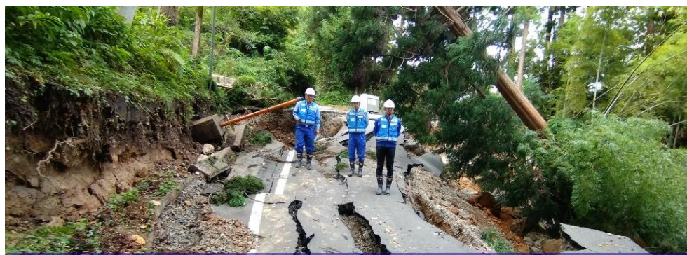
道路啓開班（珠洲市）
