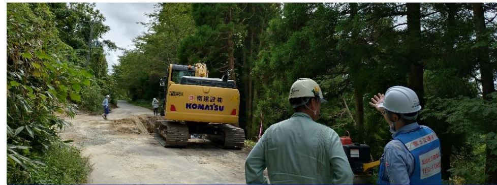
道路啓開班（珠洲市）
