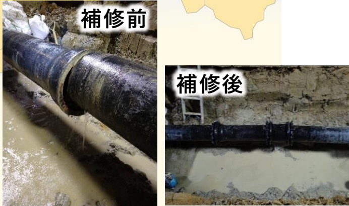
県水送水管の復旧作業
