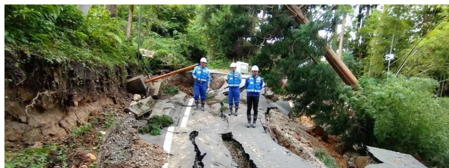
道路啓開班（珠洲市）
