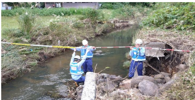
河川班（輪島市）
