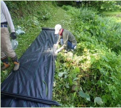
防草シート設置
