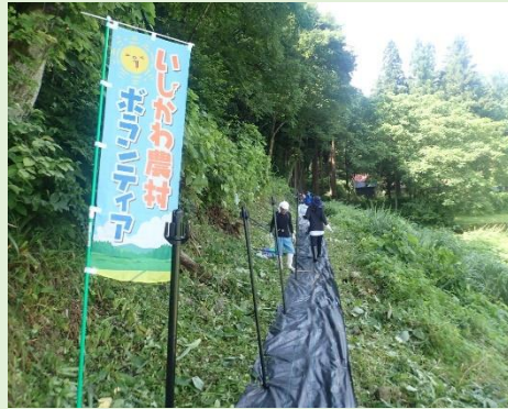
電気柵 支柱設置
