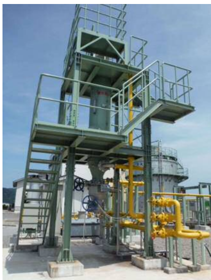
⑬脱硫装置 (連続乾式脱硫装置)
