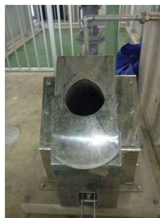
⑥し尿・浄化槽汚泥前処理設備 (夾雑物脱水装置スクリュウプレス)
