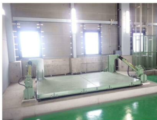
④し尿・浄化槽汚泥受入設備 (負圧式 投入口)
