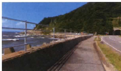
▲国道249号(珠洲市真浦町)
