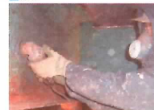
▲事後保全型補修(全塗装補修)
