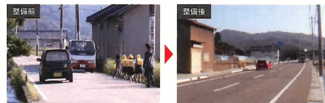
▲主要地方道 山中伊切線(塔尾バイパス)
