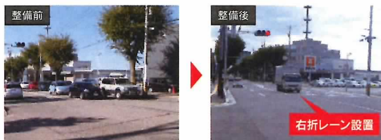
▲一般県道 金沢停車場南線(増泉3丁目交差点)(右折レーンの設置)
