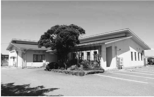
加賀市立金明地区会館（金明公民館）
