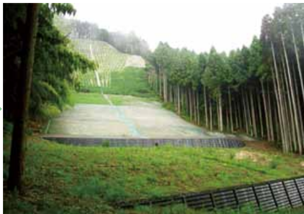
治山施設により整備(輪島市)
