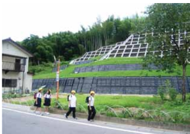
安心・安全な生活を与えてくれる治山施設(加賀市)
