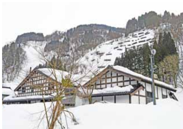
なだれ防止柵と植栽によるなだれ対策(白山市)
