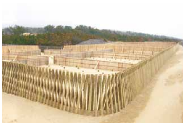
海岸工事(羽咋市)
