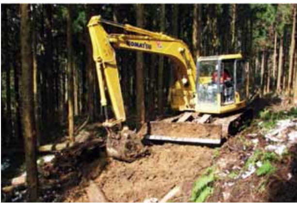
バックホウによる作業道の開設
