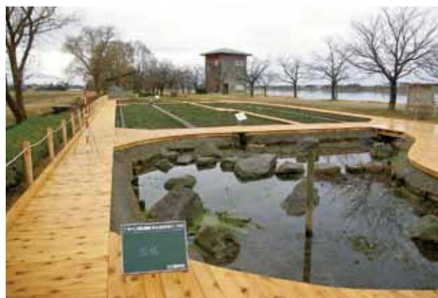
公園整備工事(小松市)
