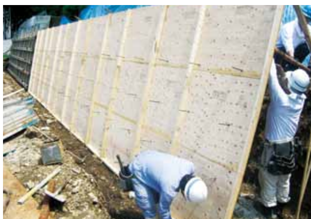
土留工事(白山市)
