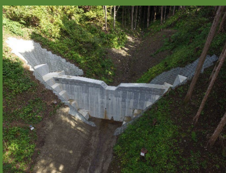
谷止工の完成写真 (中能登町)
