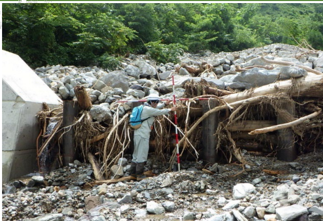
流木や巨礫を補足した治山ダム（白山市）
