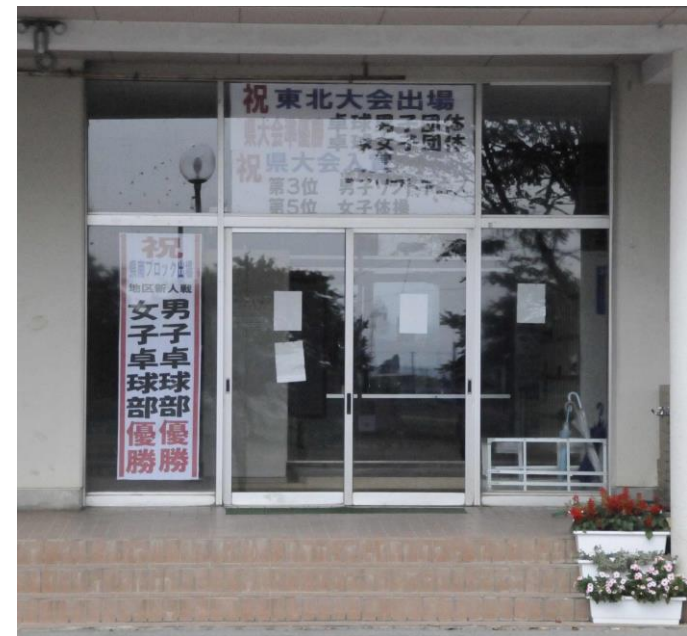
写真(上)クマが最終的に飛び込んだ正面玄関。
