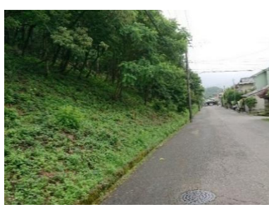
緩衝帯 整備後
