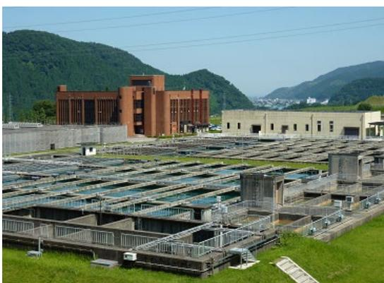
図 3.3.1-1 沈澱池（耐震補強済み）
