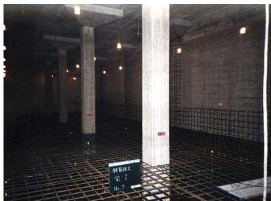
図 3.3.1-2 調整池内部（耐震補強済み）
