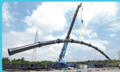
送水管の離脱防止テスト
