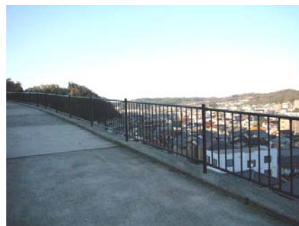
縦柵の転落防止柵を設置 (一般県道芝原石引町線／金沢市)
