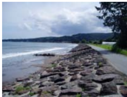
天然石の活用により、周辺景観との調和に配慮（宝立正院海岸／珠洲市）
