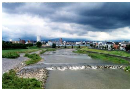
水際部にわんどや階段を整備し、水生生物、親水性に配慮（犀川／金沢市）
