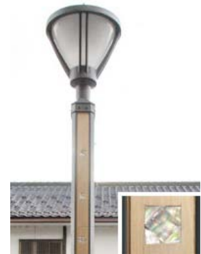
石川県木であるアテの木のパネルにアツビの殻を象嵌細工で埋め込み地域特性を演出 (都市計画道路河井町横地線／輪島市)
