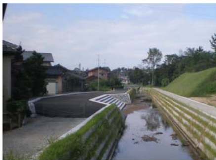
環境保全型ブロックを採用し、周辺環境との調和に配慮（大谷川／かほく市）
