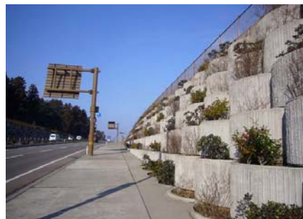
擁壁前面に植栽し、周辺景観との調和に配慮（山側環状／金沢市）
