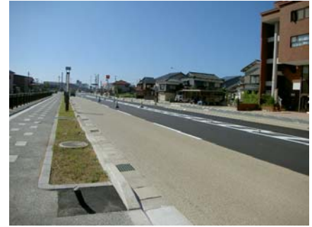
黒色のアスファルト舗装を基本としつつ、両サイドにカラー舗装も採用（国道360号／小松市）
