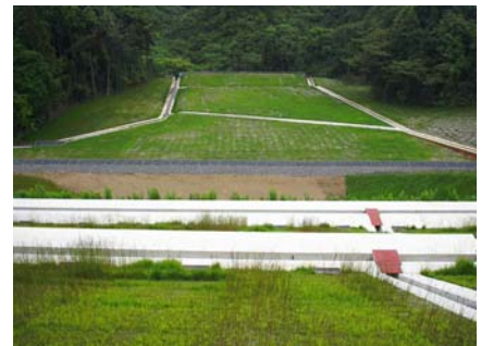
現地形になじませるよう、緩やかな盛土勾配を形成（能登有料道路／穴水町）
