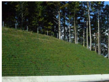
法面を緑化し、周辺景観との調和に配慮（能登有料道路／七尾市）
