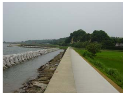
護岸前面に消波工を整然と設置（能登島海岸／七尾市）
