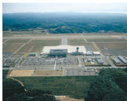
珠洲道路に面した法面部を全て緑化し、森の中の空港をイメージして整備 (能登空港／輪島市)
