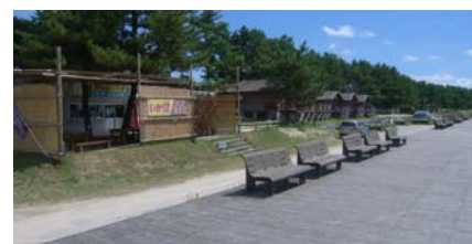
松林の植栽により、リゾートエリアの景観を演出 (富来漁港海岸/志賀町)
