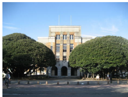
堂形のシノキを含めたファサードを残しながら改修・増築を実施 (旧石川県庁舎／金沢市)
