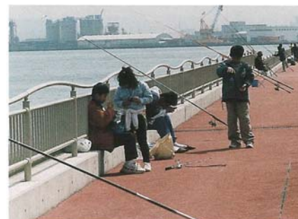
釣り客を考慮し、手摺りなどを工夫して護岸を整備（大野護岸／金沢市）
