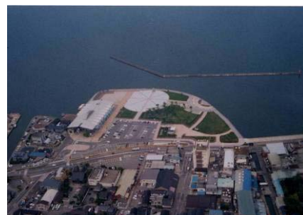
外周護岸の上部コンクリート表面に自然石を張り付け、イベント広場や親水空間を整備（七尾マリンパーク／七尾市）
