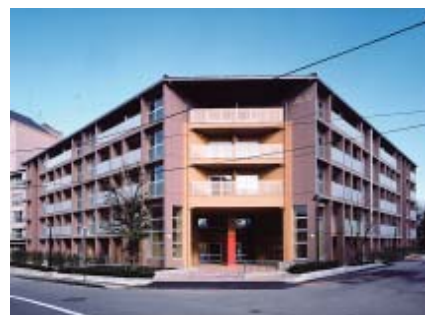
1階エントランスロビーの柱をアクセントカラーで彩色（平和町県営住宅13号棟／金沢市）
