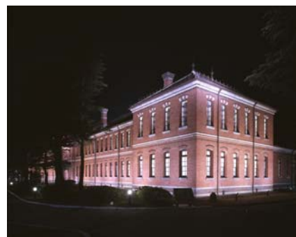
周辺景観に配慮してライトアップ（石川四高記念文化交流館／金沢市）
