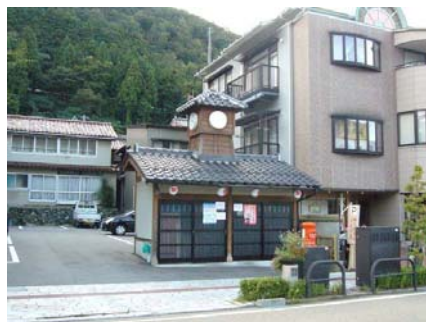
ゴミ置き場を周辺景観に配慮して整備 （山中温泉ゆげ街道／加賀市）
