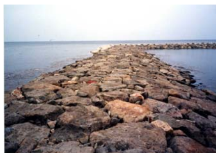
自然石を用いた突堤を整備 (庵海岸／七尾市)
