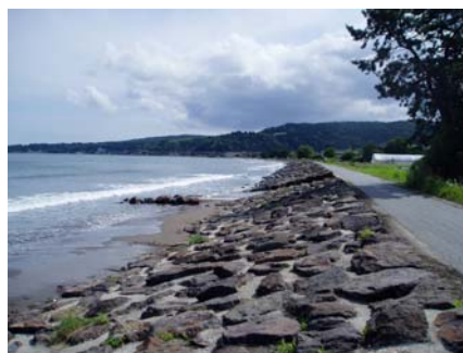
天然石を用いた緩傾斜護岸により水域と陸域の一体性に配慮 (宝立正院海岸／珠洲市)
