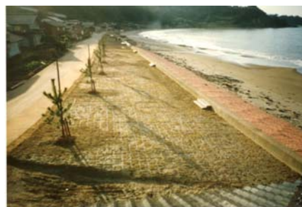
階段式傾斜護岸の背面を緑地として整備 (海岸保全施設川浦地区／珠洲市)
