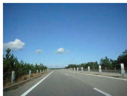
道路沿道に海岸景観を演出する松林を植樹 (能登有料道路/かほく市)
