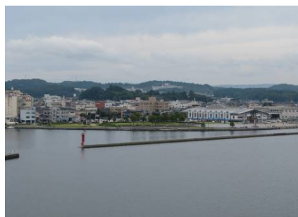
港町の風景に溶け込むよう建物の高さを抑え、青系の色彩とし、周囲には植栽を整備 (七尾マリンパーク／七尾市)
