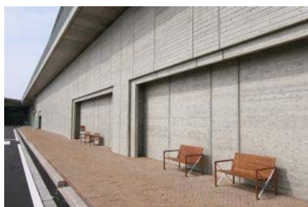
コンクリートの外壁に、杉板型枠により木目調の表情を演出 (いしかわ総合スポーツセンター／金沢市)
