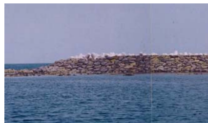
自然国定公園にありレジャー観光地としても観光客が訪れるため、堤体に自然石を使用し、周辺の岩礁や島との調和に配慮（比那漁港／能登町）
