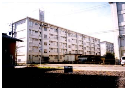
建替え前（箱形の無機質な建物）
