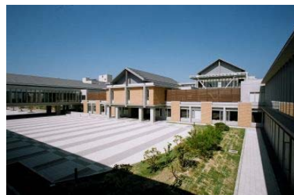
外壁は手取川の土色をイメージしたせっき質タイルによる土色でまとめ、周辺景観に配慮（石川県立大学／野々市町）
