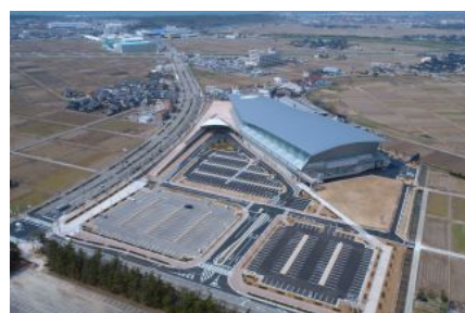
緩やかな勾配の大屋根とし、周辺環境との調和に配慮（いしかわ総合スポーツセンター／金沢市）
