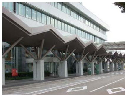
奥能登の山々の連なりをイメージして 歩道部の屋根を整備 (能登空港／輪島市)
