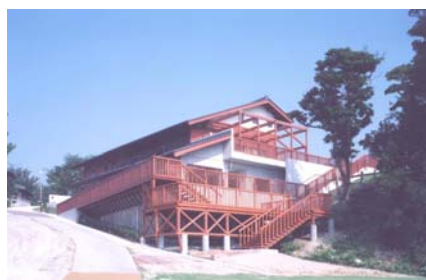
九十九湾に面する周辺景観に溶け込むよう配慮（海の自然体験館／能登町）
