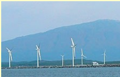
景観アセスメントの対象 (例) 風力発電用風車など
