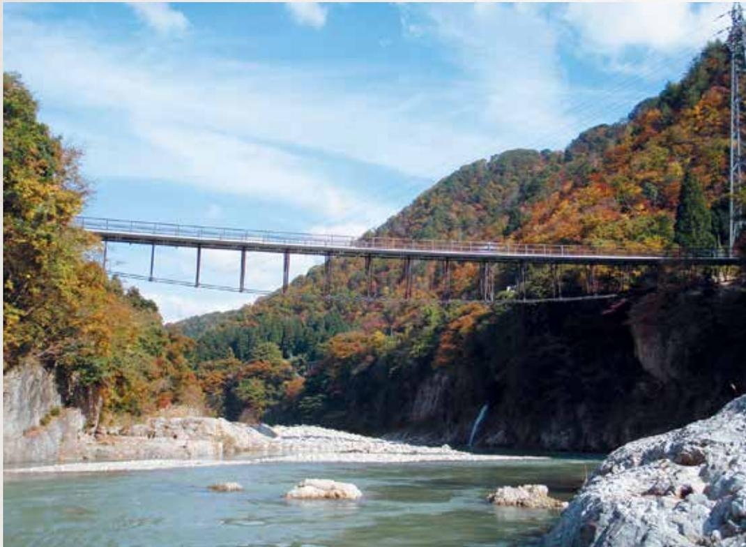
県立自然公園区域内であることから、主塔のないスレンダーな構造としている。具体的には、外ケーブル併用吊床版橋という構造で、国内で2番目に採用した珍しい橋である。自然の中で目立ち過ぎず、周辺の景観と調和したデザインである。
