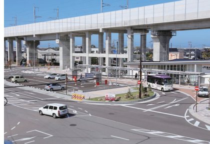
野々市駅南広場(H25.10完成)
