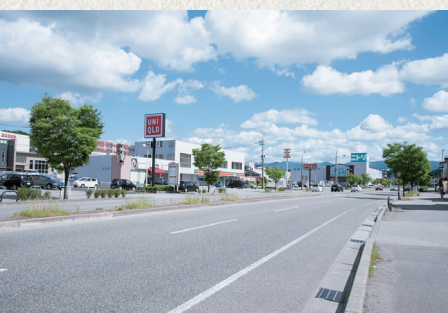
山側環状(田上町 地内)
