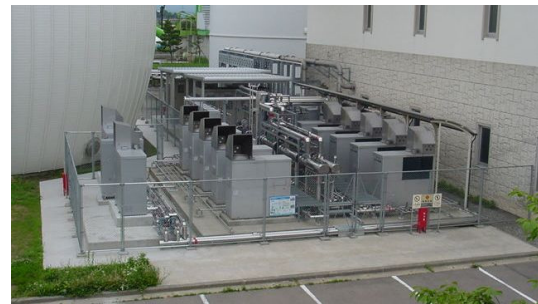
汚泥処理で発生したメタンガスで発電 (犀川左岸浄化センター<金沢市>)
