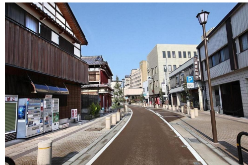
街路整備に合わせた街並みの一体的整備 (片山津中央線<加賀市>)
