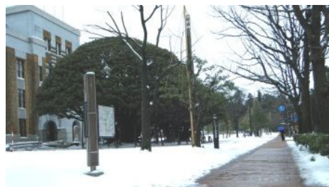
歩行者に優しい無散水消雪の歩道 (広坂通り<金沢市>)
