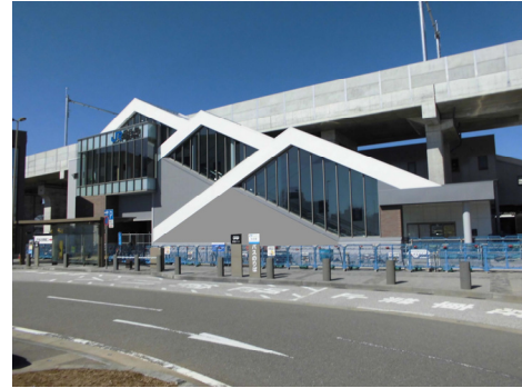
交通結節点の充実強化 (JR松任駅自由通路・橋上駅舎<白山市>)
