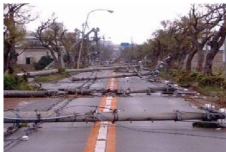
台風被害による電柱倒壊状況
