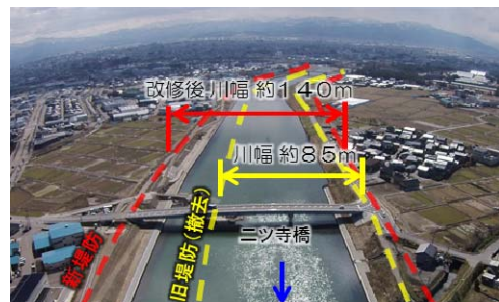
県内の河川改修事業 (上：動橋川 下：犀川)
