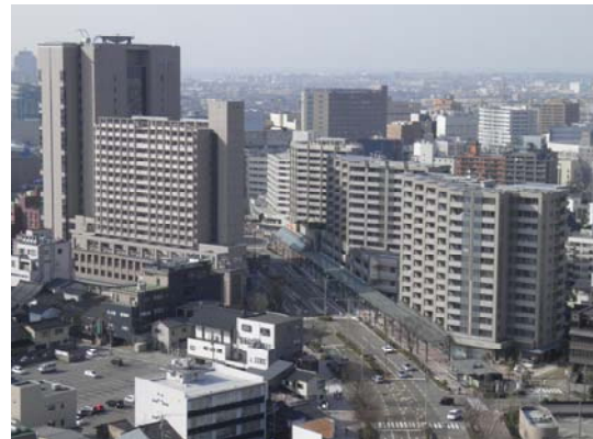
市街地再開発事業 (金沢駅武蔵北地区<金沢市>)
