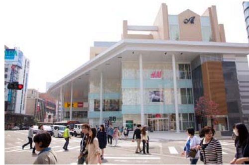
市街地再開発事業によるまちなかの更新 (片町A地区市街地再開発事業<金沢市>)
