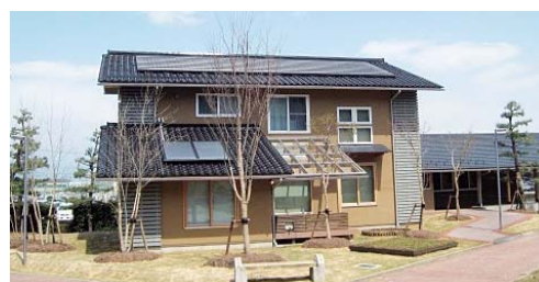
いしかわエコハウス (出典：いしかわの土木 2016)
