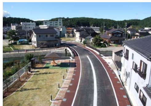
定住の受け皿となる住宅地の整備 (大町川島地区<穴水町>)
