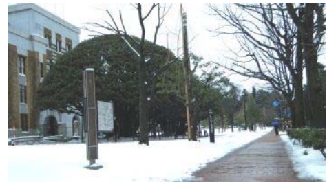
歩行者に優しい無散水消雪の歩道 (広坂通り<金沢市>)
