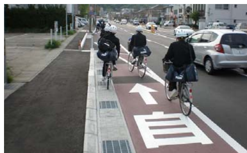
自転車通行空間の整備 (一般県道東金沢停車場線<金沢市>)
