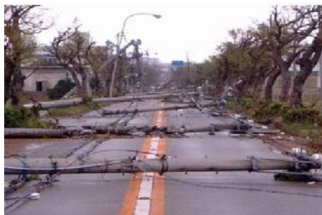
台風被害による電柱倒壊状況
