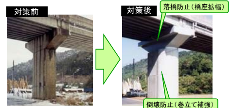
緊急輸送道路の橋梁耐震補強
